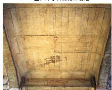
■天井部の作業に
