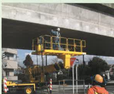
■高所天井部の研掃作業に
