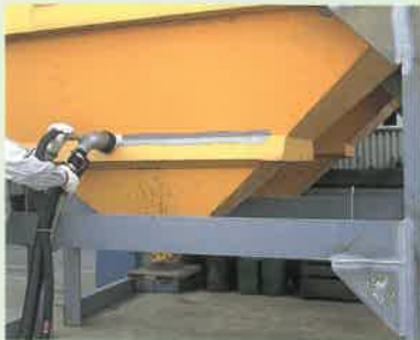
■溶接部の作業に
